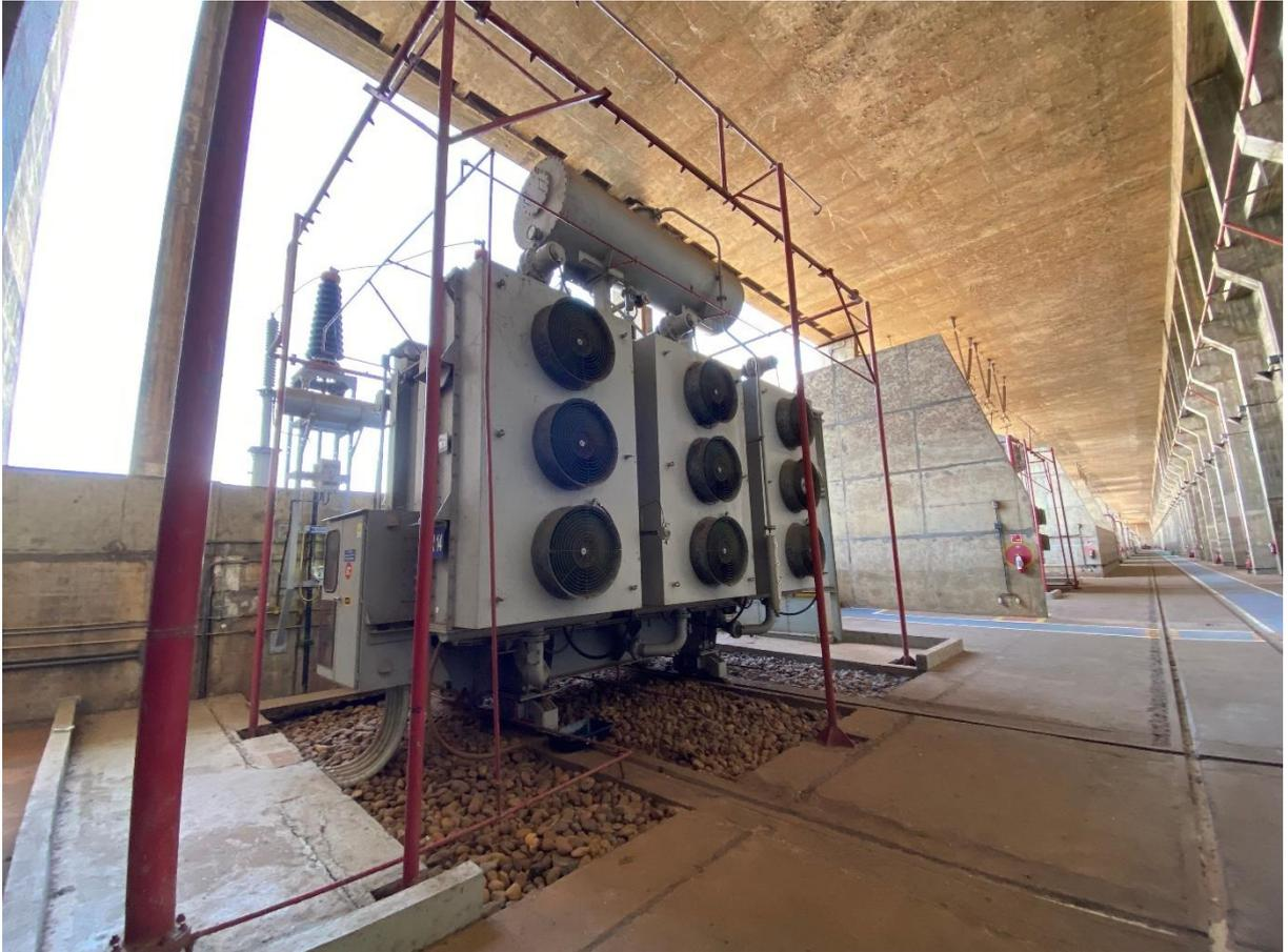
*Figura 38- Transformador de 138 KV para abastecimento de Três lagoas e cidades vizinhas*
