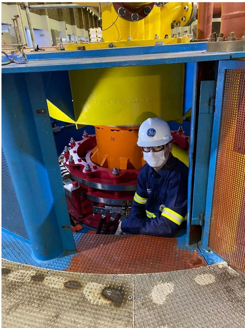
*Figura 29 - Anel coletor e, escovas responsáveis pela excitação do rotor*
