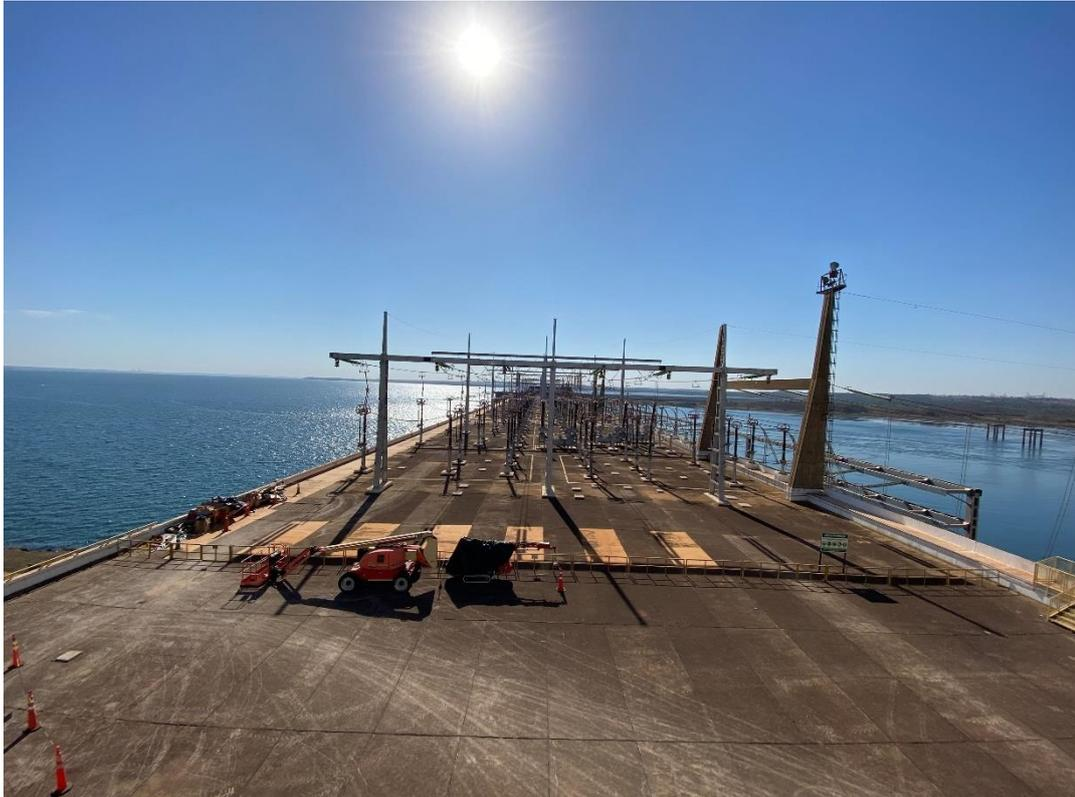
*Figura 39- Acima da casa de força é aonde fica a subestação de 440 KV*
